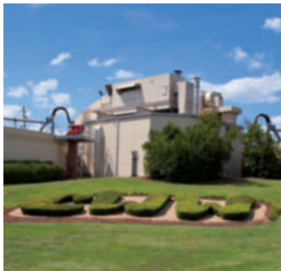
Гидравлические сооружения в Колумбе обеспечивают очистку сточной воды для 230 000 жителей.
